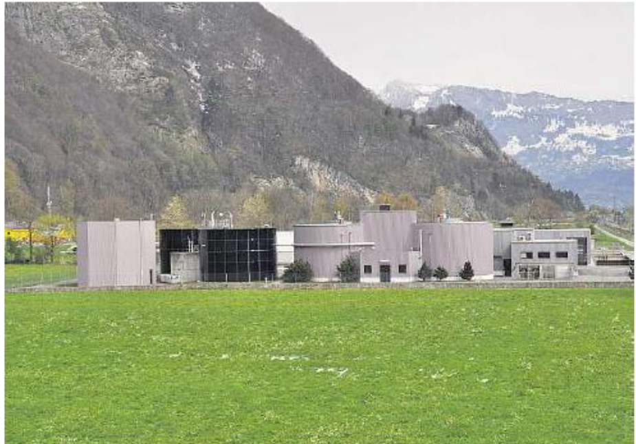
Soll noch dieses Jahr mit einer Fotovoltaikanlage bestückt werden: Die ARA Saar im Sarganser Aeuili.
